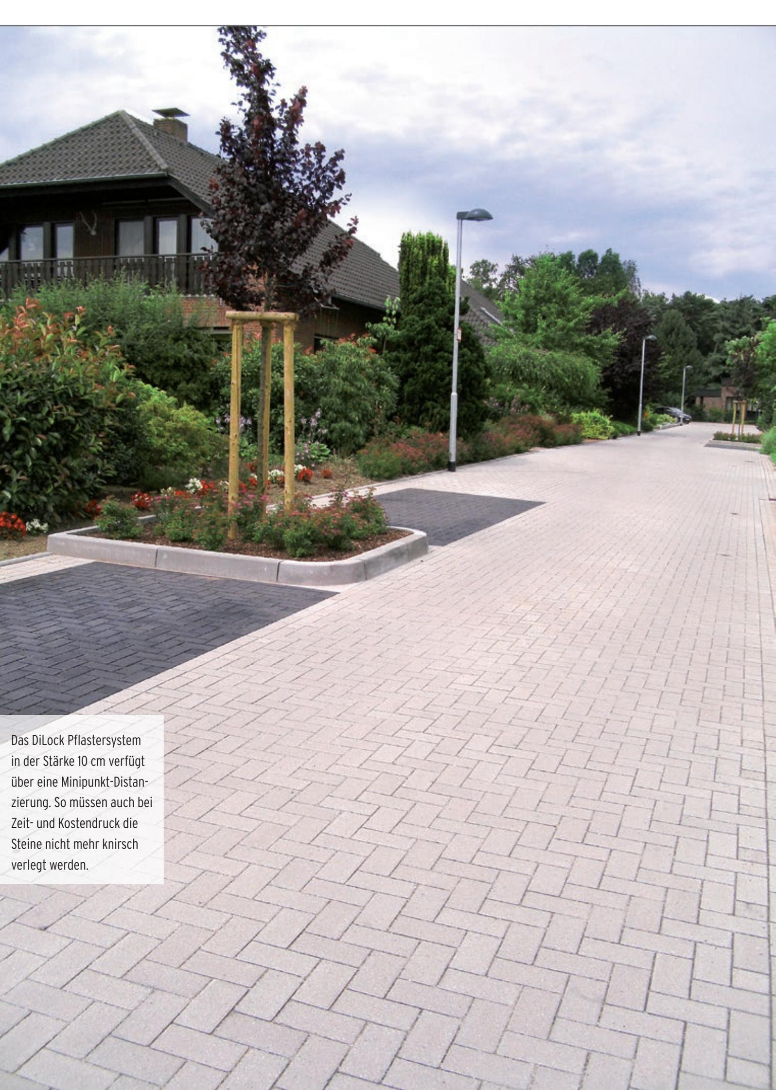
Das DiLock Pflastersystem in der Stärke 10 cm verfügt über eine Minipunkt-Distanzierung. So müssen auch bei Zeit- und Kostendruck die Steine nicht mehr knirsch verlegt werden.
